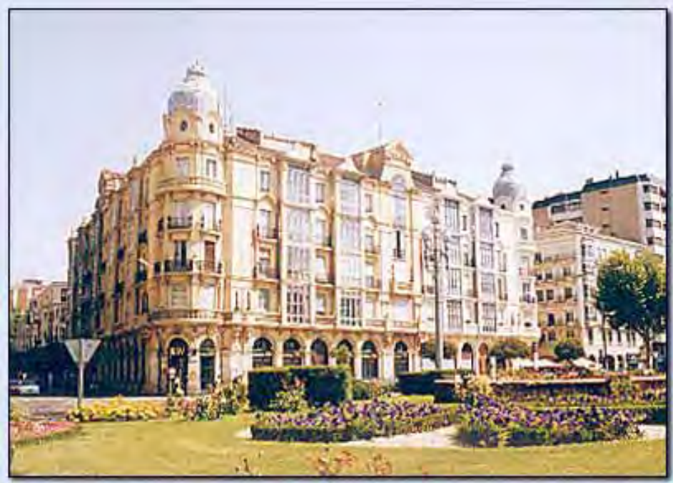
Figura 1a. Edificio Mantilla. Mantilla Building
