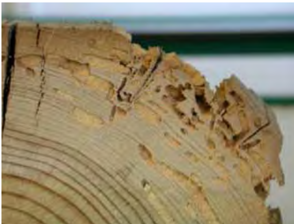
Figura 14. Tornillo en zona atacada (lectura de 1,25 kN).
