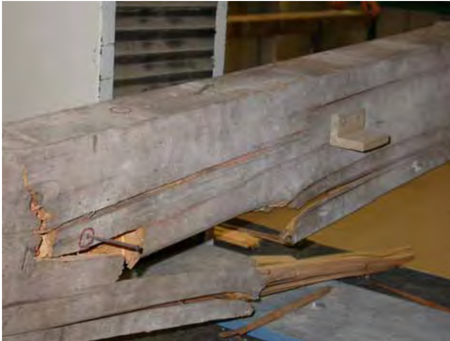
Figura 7. Rotura a flexión de una de las viguetas ensayadas. Rupture to flexion of one of the tested beams.
